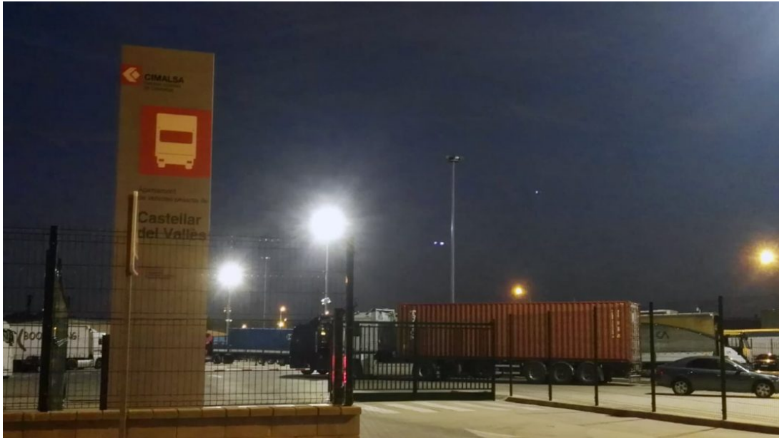
Instalaciones del Truck Castellar con su nueva iluminación LED
